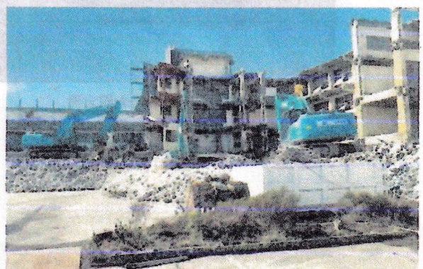
解体中の旧北部コミュニティセンター
