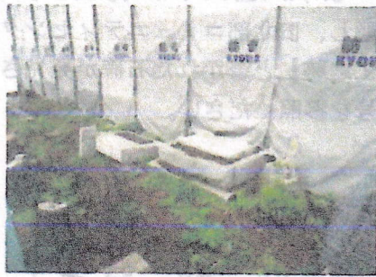
建物を解体するため碑を寝かした
