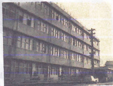
昭和 38 年に完成した校舎
