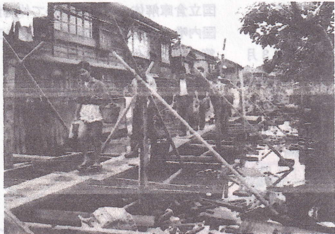
市工場の道路に架設の橋
