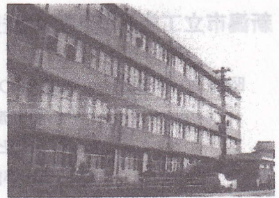
昭和 58 年に完成した校舎
