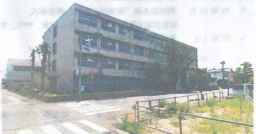
バス通りにあった解体前の校舎
