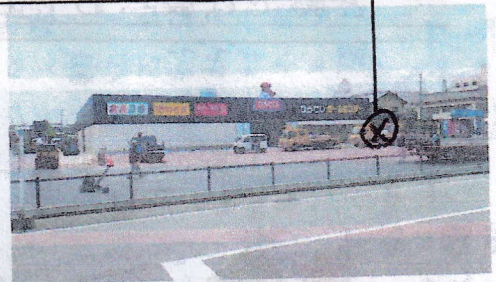
8月1日オープンに向けて店舗の建設も急ピッチ
